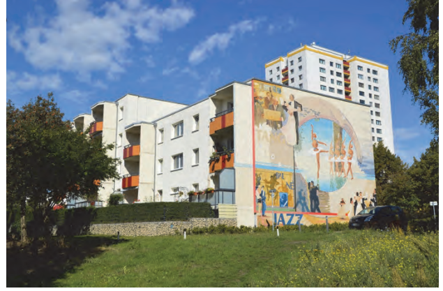
写真6 上階を「減築」し妻面に絵を描いた集合住宅。マルツァーン団地内。
