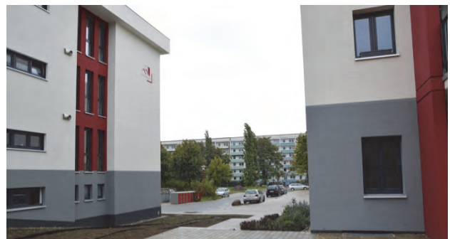
写真2 上階を削り「減築」された集合住宅（手前）。以前は奥に見えるような6階建てだった。設備更新で高家賃とした。
