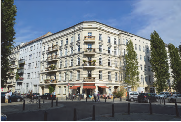
写真8 古い集合住宅の改善事業によって雰囲気の良い街区が徐々に形成されつつあるプレッツラウアーベルグ地区の様子。
