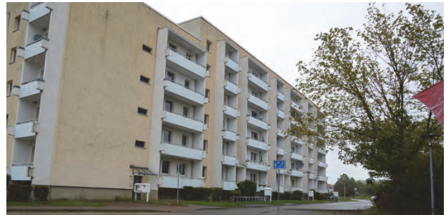
写真3 取壊し予定の賃貸集合住宅。6階建てだがエレベーター設備がない。（シリア難民受入予定のため一時凍結されていた）
